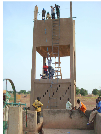
L'ancien forage avec sa pompe à manivelle et le château d'eau en cours d'installation.
